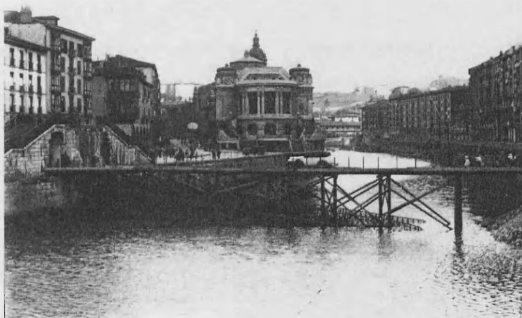
Fig. 5.14 Provisional gangway supported on the destroyed San Francisco bridge (Archivo Foral de Bizkaia).
