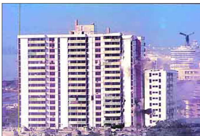
Figure 5.13. Las Acacias demolition. Dec. 17. 2000.
